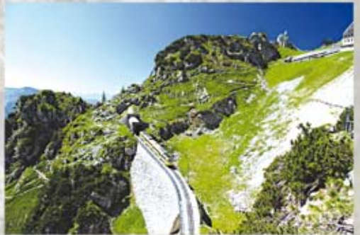
Tunnel, Kircherl und hohe Mauer
